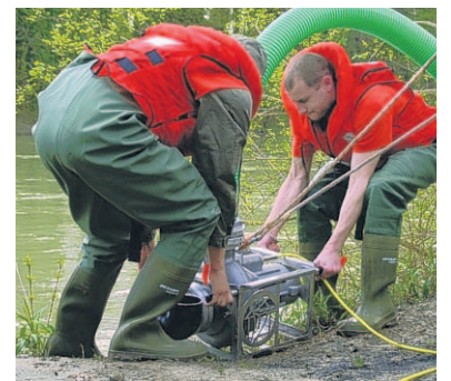
Zwei Pioniere beim Absenken der Tauchpumpe in der Aare.
